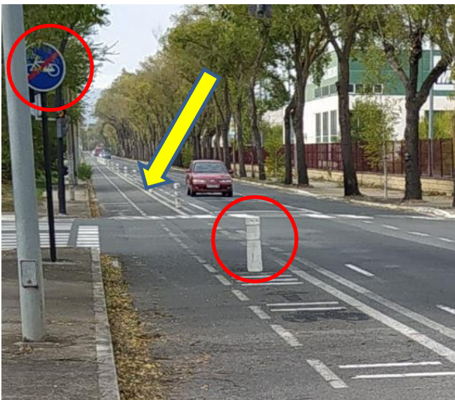
En el sentido E \rightarrow W , al llegar al cruce con La Peña, una señal vertical y un bolardo (círculos rojos) indican la finalización del carril bici, sin embargo sigue existiendo infraestructura (flecha amarilla) y para los que acceden desde la calle La Peña, no se encuentran ni bolardo ni señal vertical y la única indicación, de difícil interpretación, es la pintura negra sobre los pictogramas
