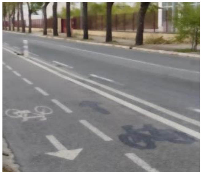
En el sentido E \rightarrow W , al llegar al cruce con La Peña, una señal vertical y un bolardo (círculos rojos) indican la finalización del carril bici, sin embargo sigue existiendo infraestructura (flecha amarilla) y para los que acceden desde la calle La Peña, no se encuentran ni bolardo ni señal vertical y la única indicación, de difícil interpretación, es la pintura negra sobre los pictogramas
